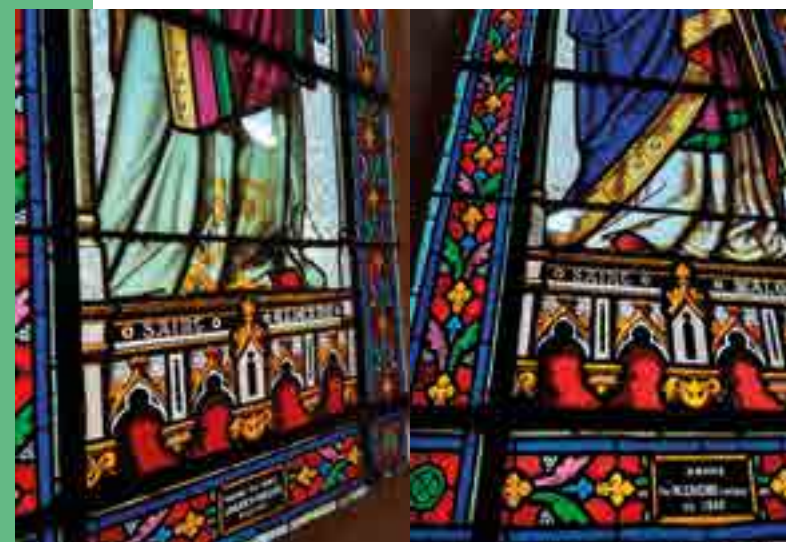
Les vitraux du cœur avant travaux.
