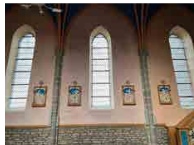
Les vitraux avant travaux.
