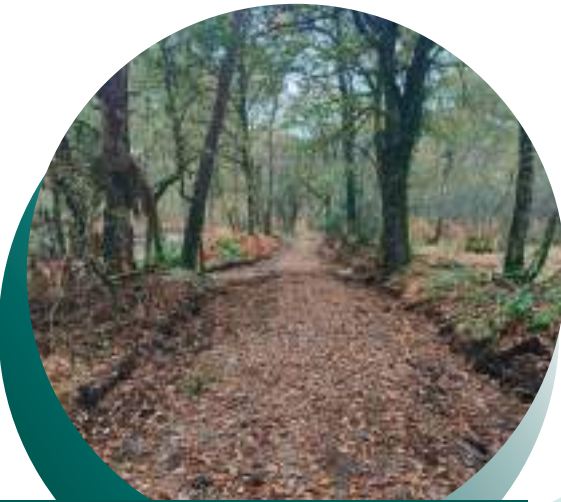
Chemin des 7 bornes après travaux
